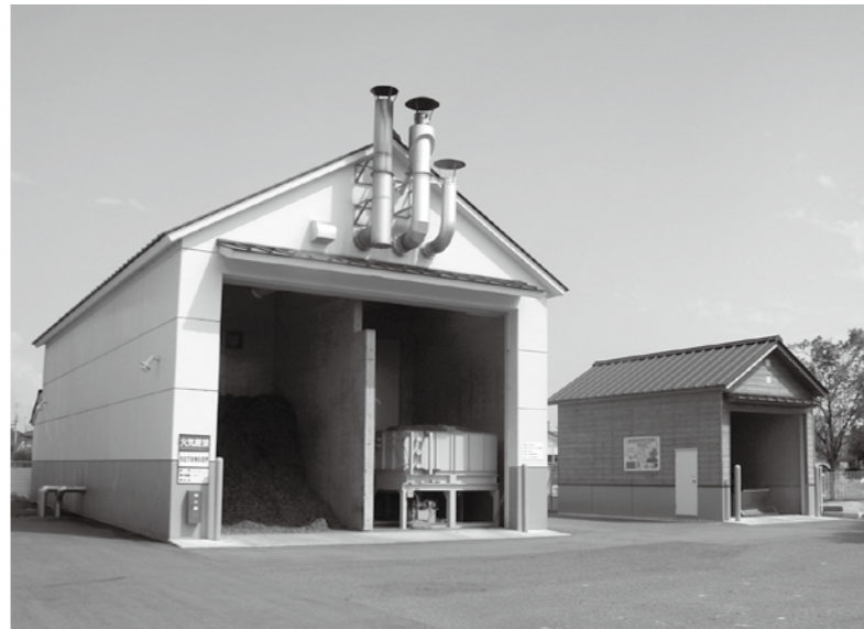
高島市熱供給施設
