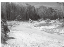
鴨川の災害復旧作業現場
