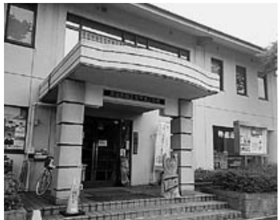
▲市商工会マキノ支所
