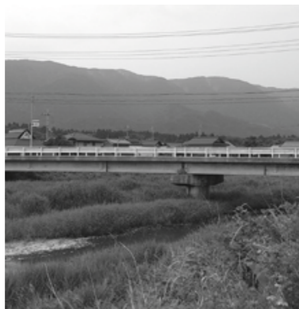
耐震調査を行う老朽化橋
