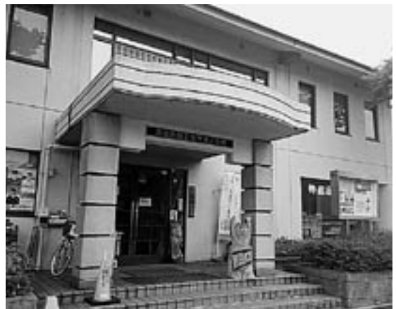
▲市商工会マキノ支所
