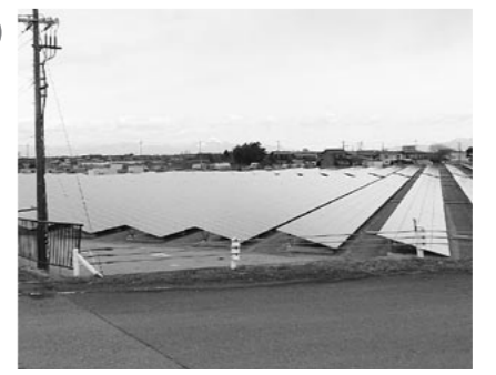
▲太陽光発電設備が建設された市内用地
