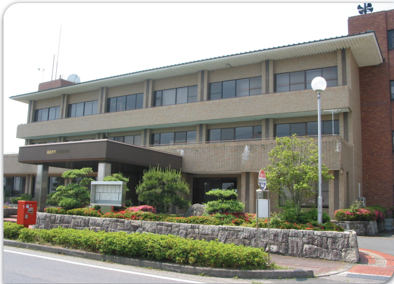
高島市役所 高島支所（昭和57年竣工）
