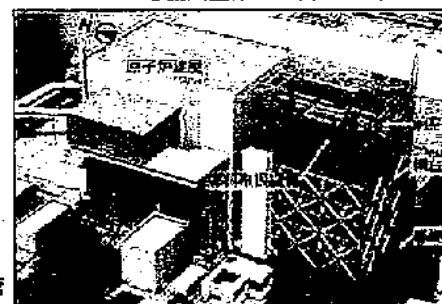
2号機燃料取り出し用構台(イメージ)
