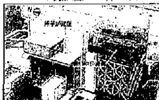
2号機燃料取り出し用構台(イメージ)
