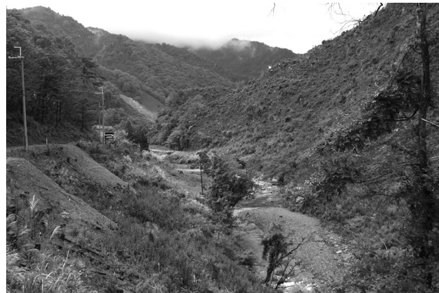
北川ダム建設予定地
