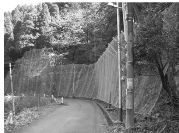
市道天増川道線落石防護網設置工事
