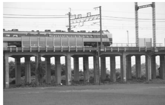
設置工事が進む湖西線暴風壁
