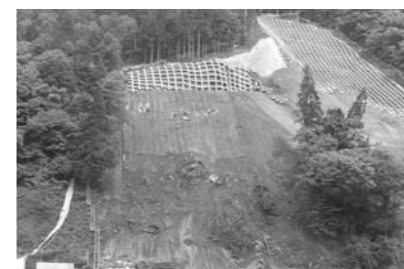
R367 朽木村井の崩落現場
