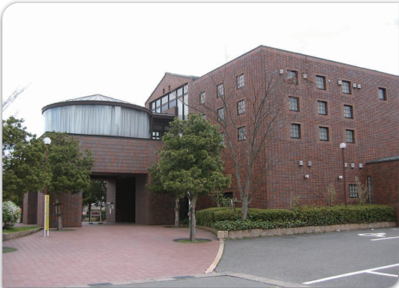
安曇川図書館（平成6年4月竣工）
