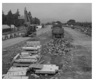
国道161号バイパス工事現場
