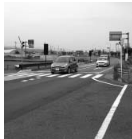
国道161号安曇川工区
