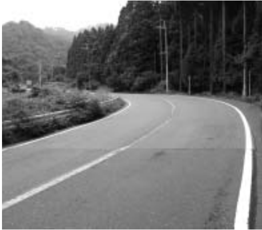
国道303号追分工区
