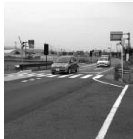
国道 161 号安曇川工区
