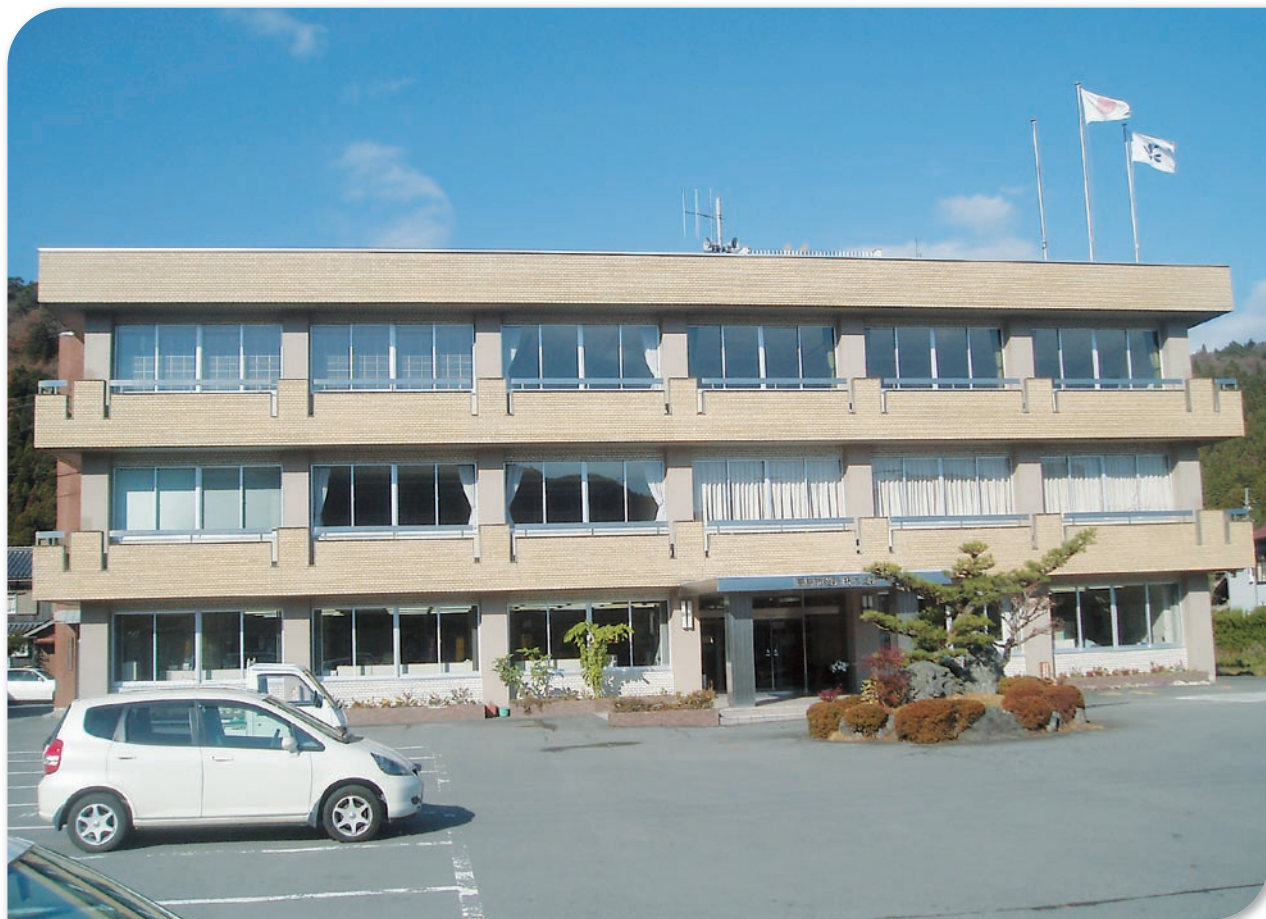
高島市役所 朽木支所（昭和49年竣工）
