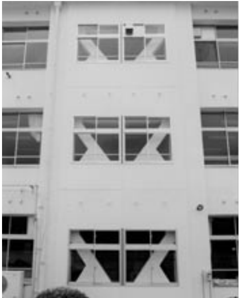
耐震工事が完成した校舎
