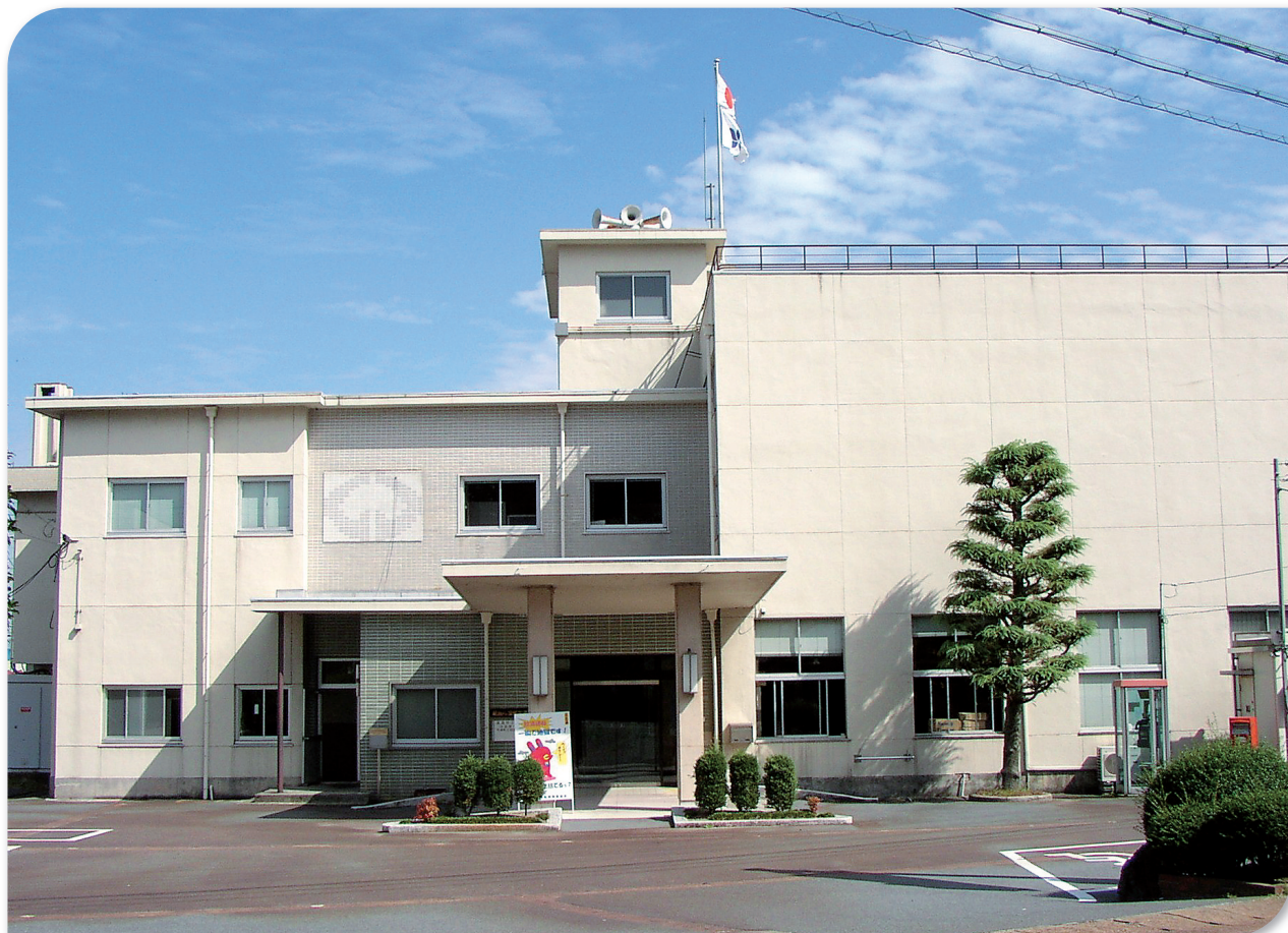
高島市役所 今津支所（昭和33年竣工）
