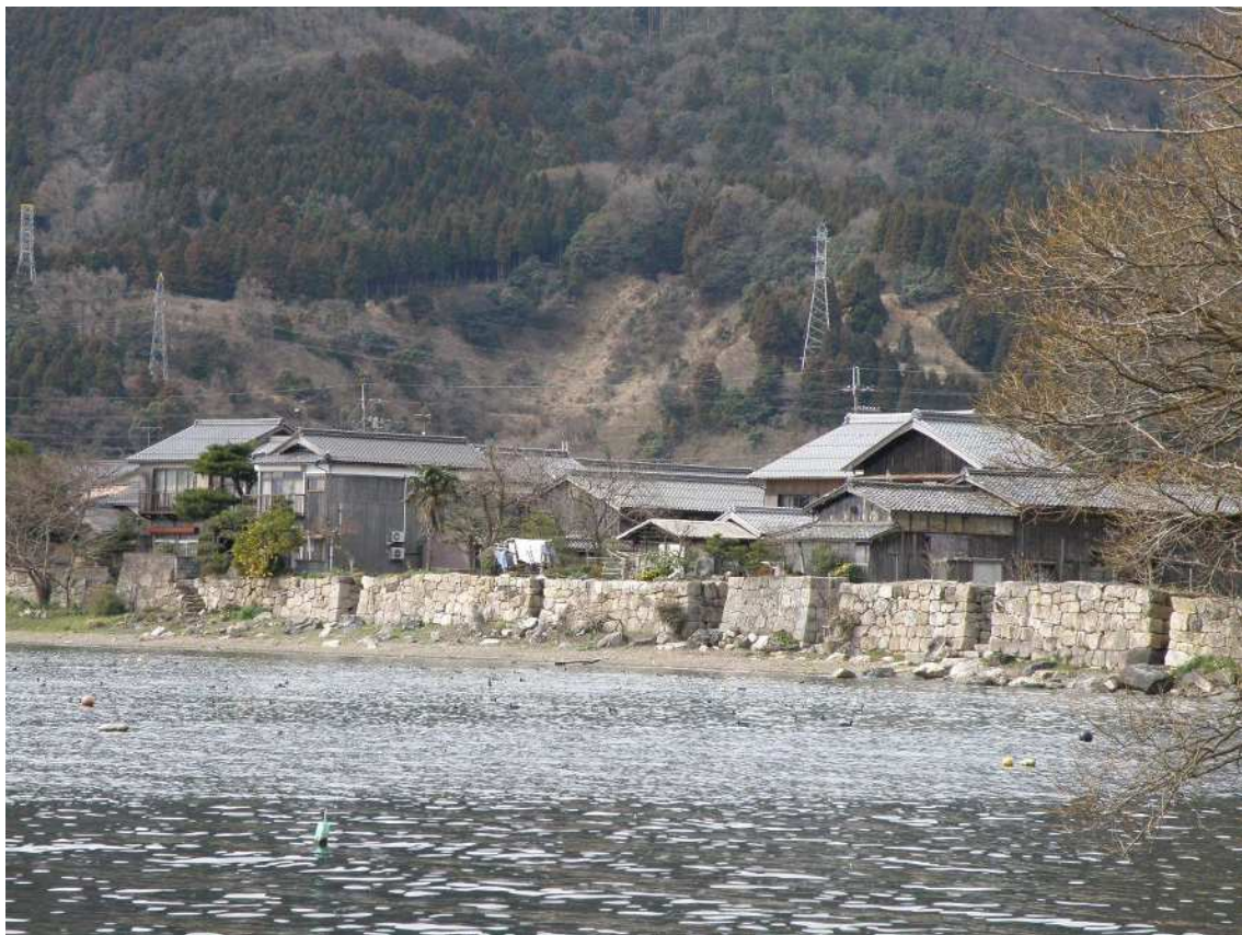
〈高島市マキノ町海津・西浜 石積（重要文化的景観）〉
