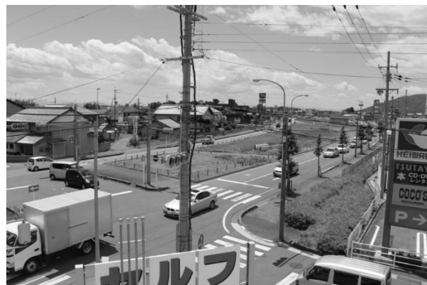
国道161号線安曇川交差点付近
