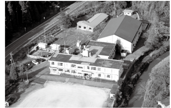
昭和 57 年に竣工した校舎
