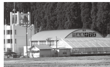
旧マキノ北小学校施設の現状
