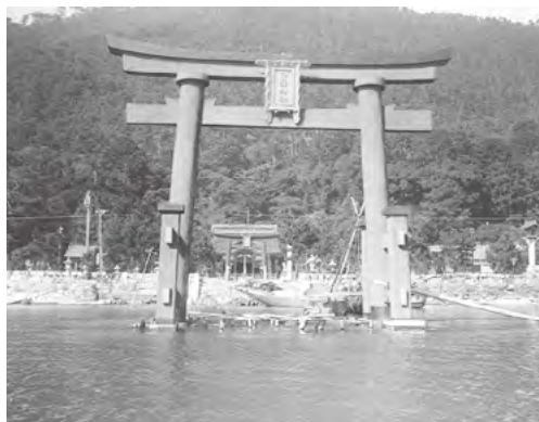
建設中の大鳥居(昭和12年)
