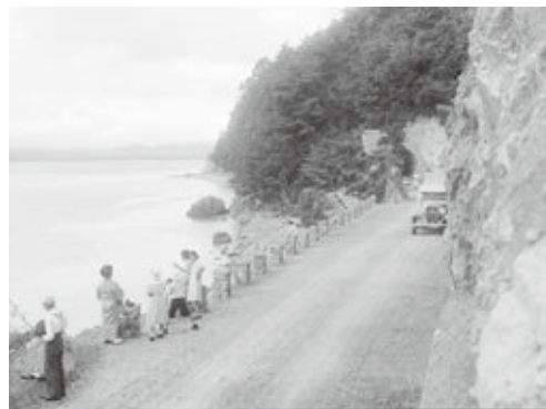
大崎隧道 (開通当時のようす)
