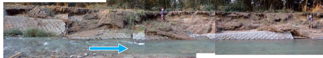
鴨川野田橋下流左岸護岸欠損
