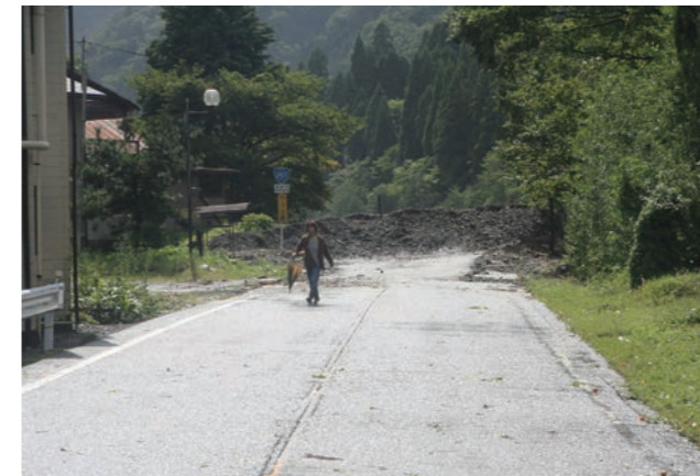
日の口谷付近の被害(朽木村井)
