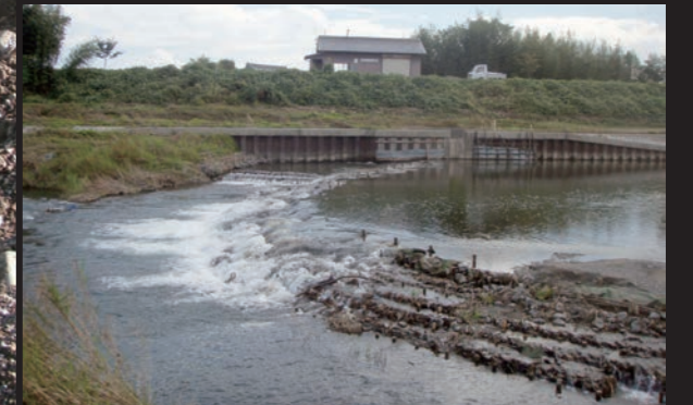
安曇川に設置していたやな(漁業)が流出(安曇川町北船木)
