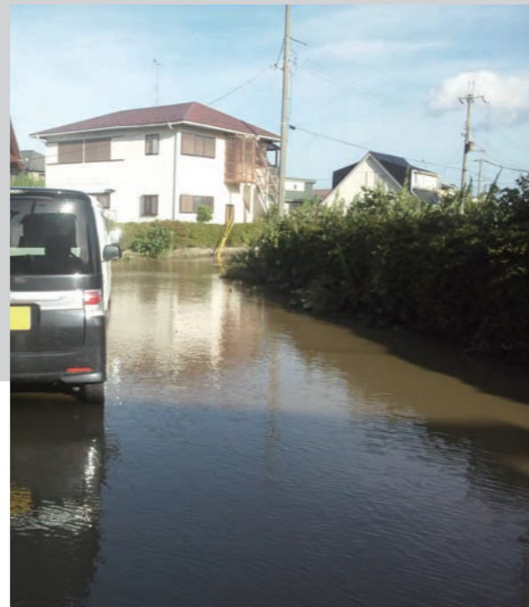
冠水した民家と道路(高島萩の浜)
