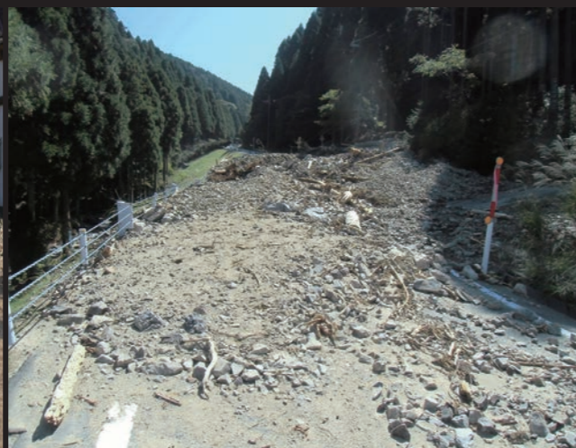
土砂崩れにより道路をふさぐ(朽木スキー場)
