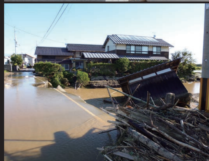
濁流に押し流された建物(高島南鴨)
