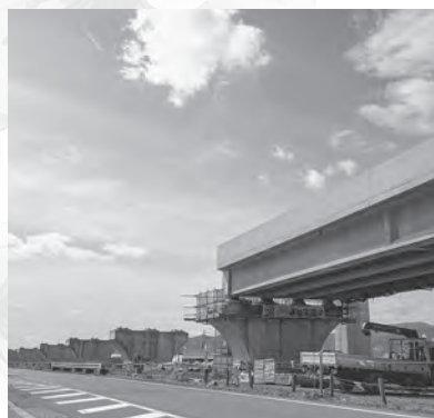
国道161号 安曇川地区立体化
