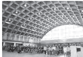
3 月 朽木東小学校・朽木中学 校屋内運動場竣工
