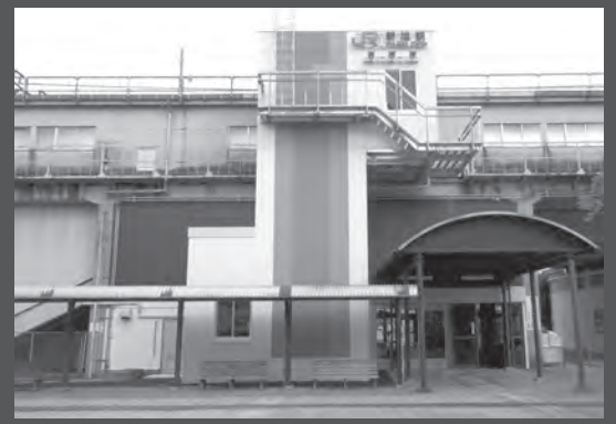
↑新旭駅のエレベーター
