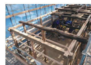
復原工事中のようす
