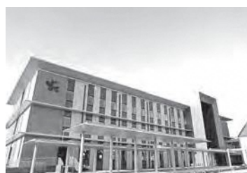
9月 市役所本庁舎新館が完成
