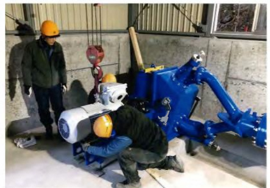
【発電機の設置】
