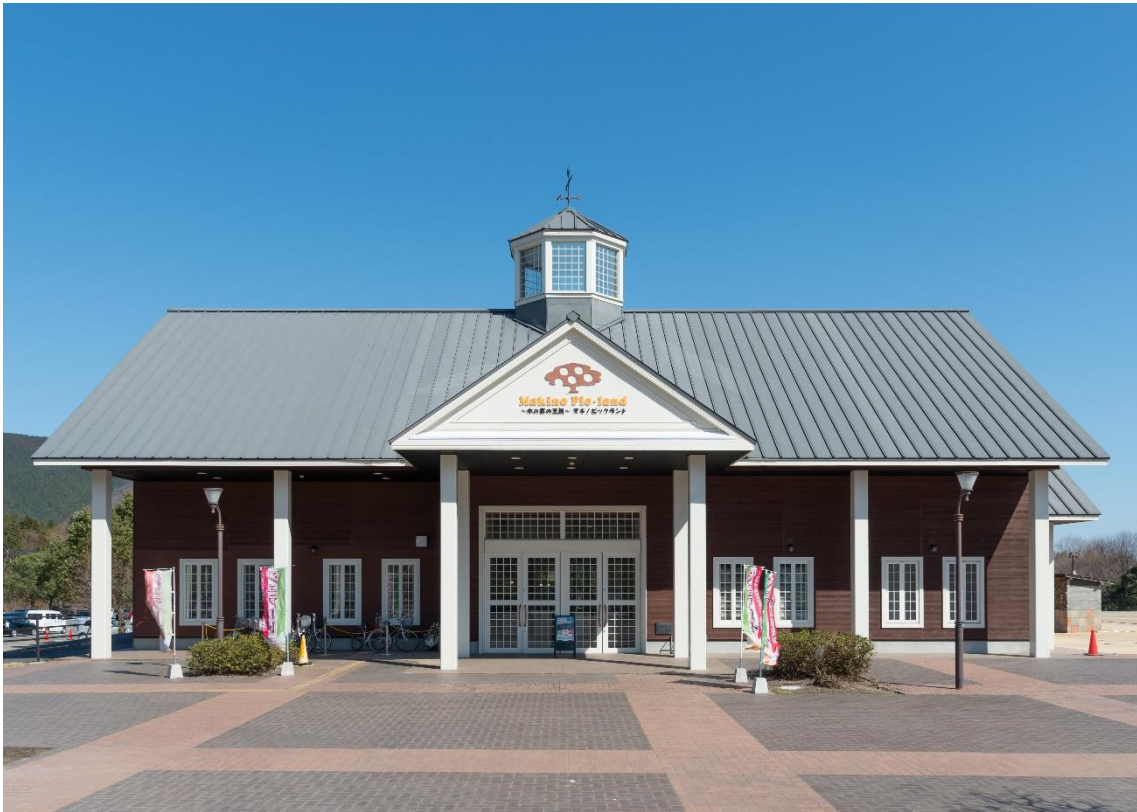
センターハウス棟外部(西面)
