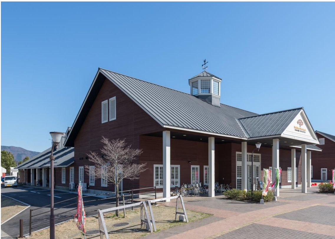
センターハウス棟外部(北西面)
