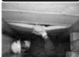
床下に断熱ボードを取り付ける
