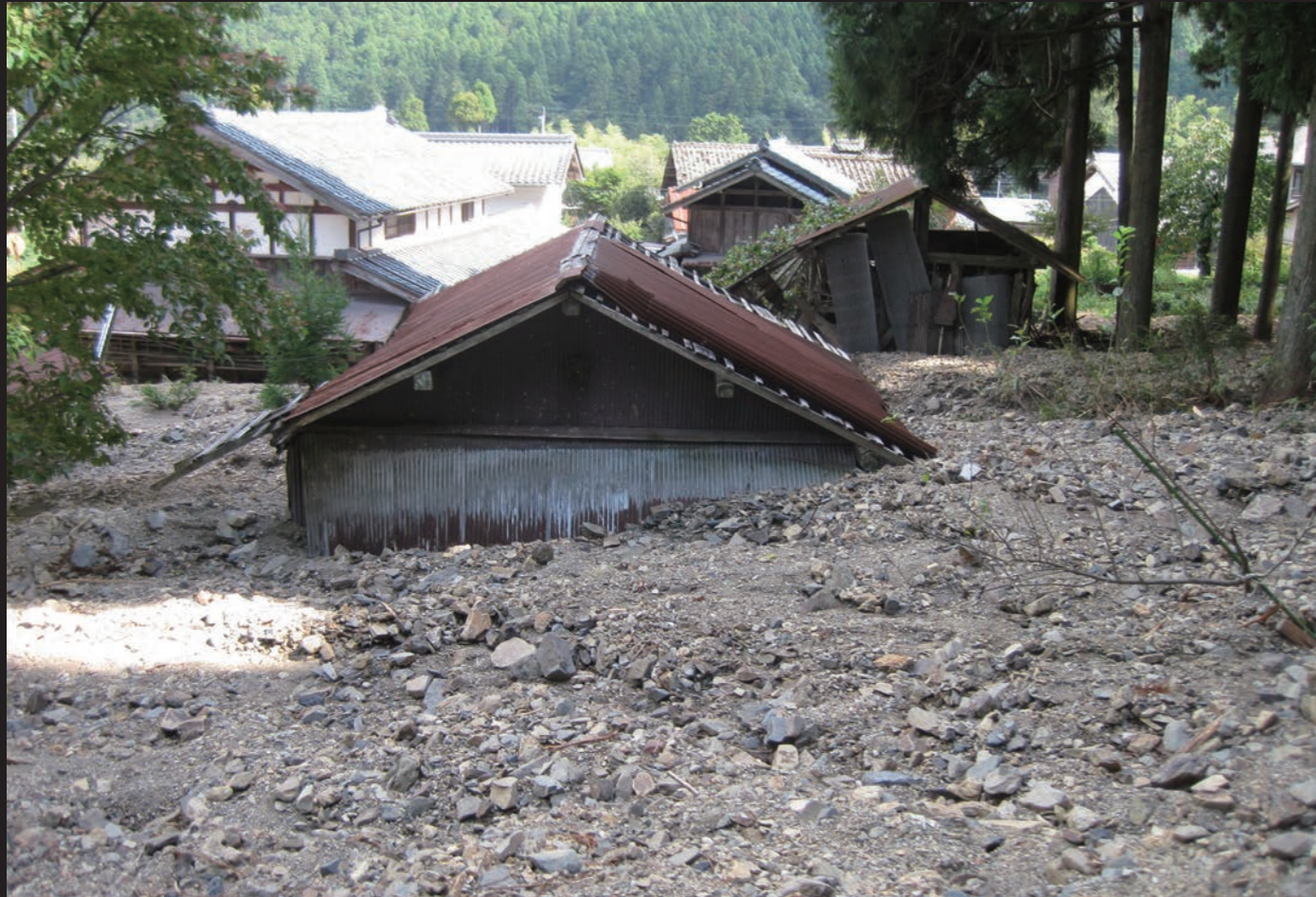
崩れた土砂で埋まった家(朽木古川)
