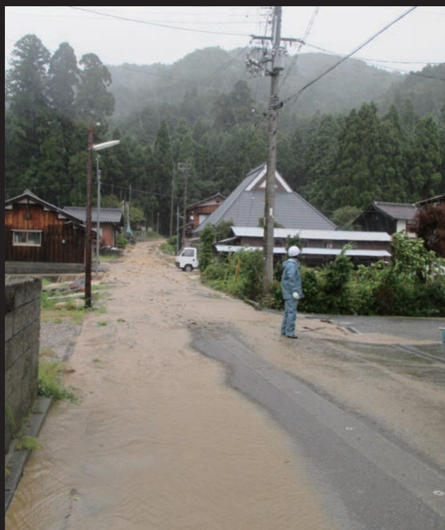
集落内の道路が冠水(マキノ町上開田)
