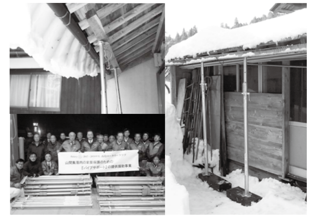
パイプサポートを設置した状態
