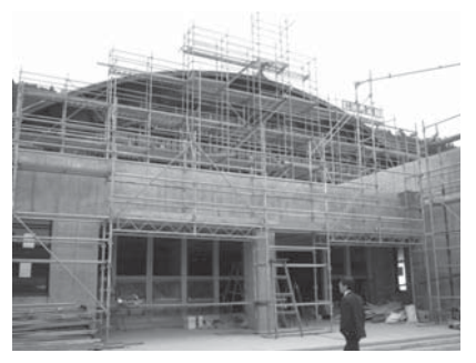
▲朽木小中体育館建築現場の状況
