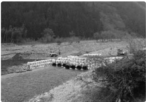
工事用仮設道路
