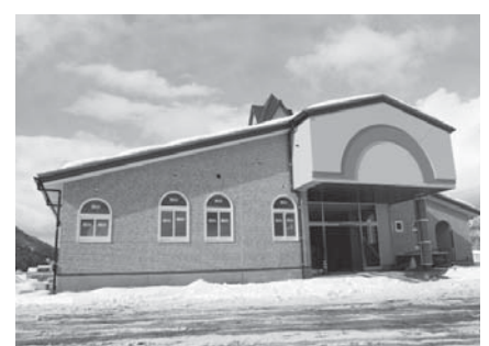
▲愛隣保育園建築現場の状況
