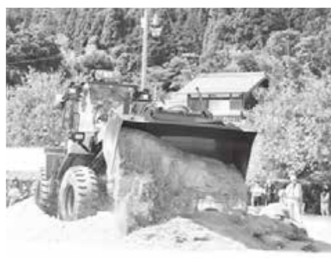
土砂除去作業実動訓練
