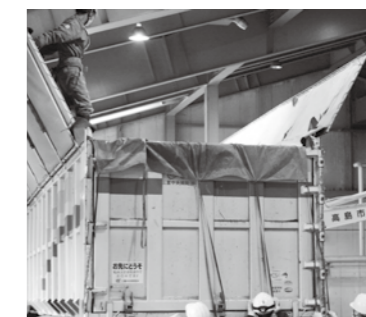
③シートを被せて両側から上蓋をする
