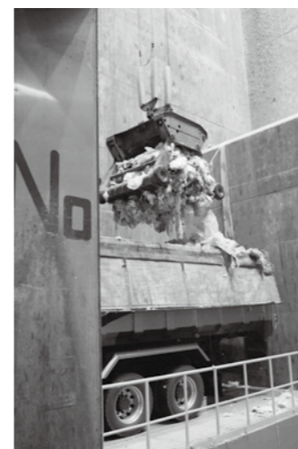
①ごみクレーンでごみを積み替える(一掴みで約1t)
