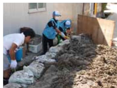
水路の泥出し（南鴨）
