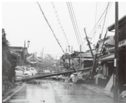
電柱の倒壊で被害を受ける民家 (マキノ町海洋)
