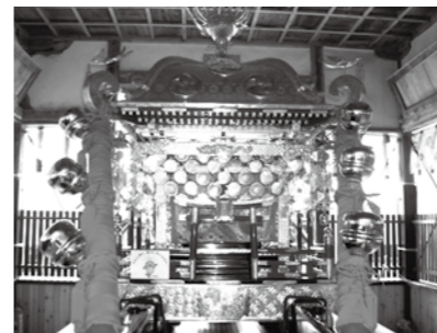
深溝区自治会(御輿の修繕)
