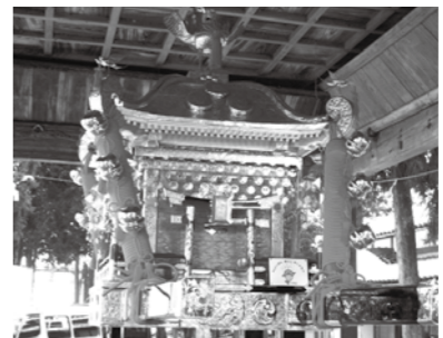
北仰区(御輿の修繕)
