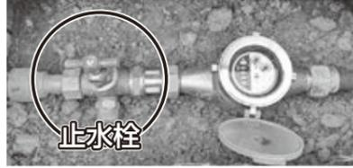
※凍結部分に直接熱湯をかけると、水道管破損の原因になります。
