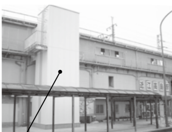
近江高島駅に設置されたエレベーター
