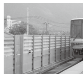
現在設置されている防風柵 (近江舞子駅)
