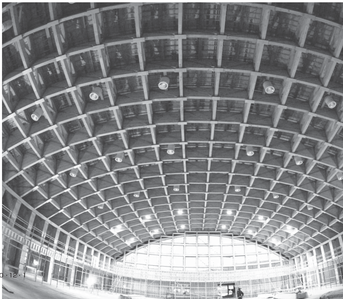
建設中の 朽木東小・朽木中学校体育館▶ （木造アーチ梁）
