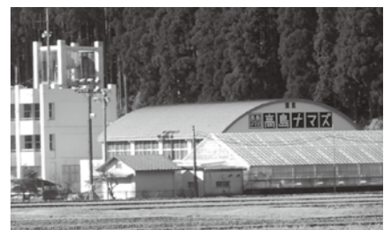
旧マキノ北小学校施設の現状
