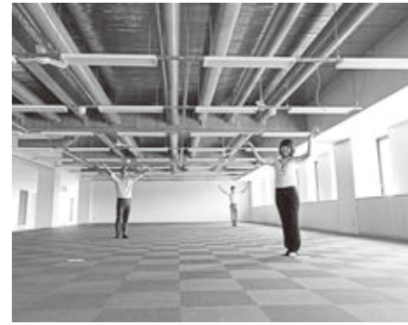
環境に配慮した 高効率空調機器やLED照明を整備
